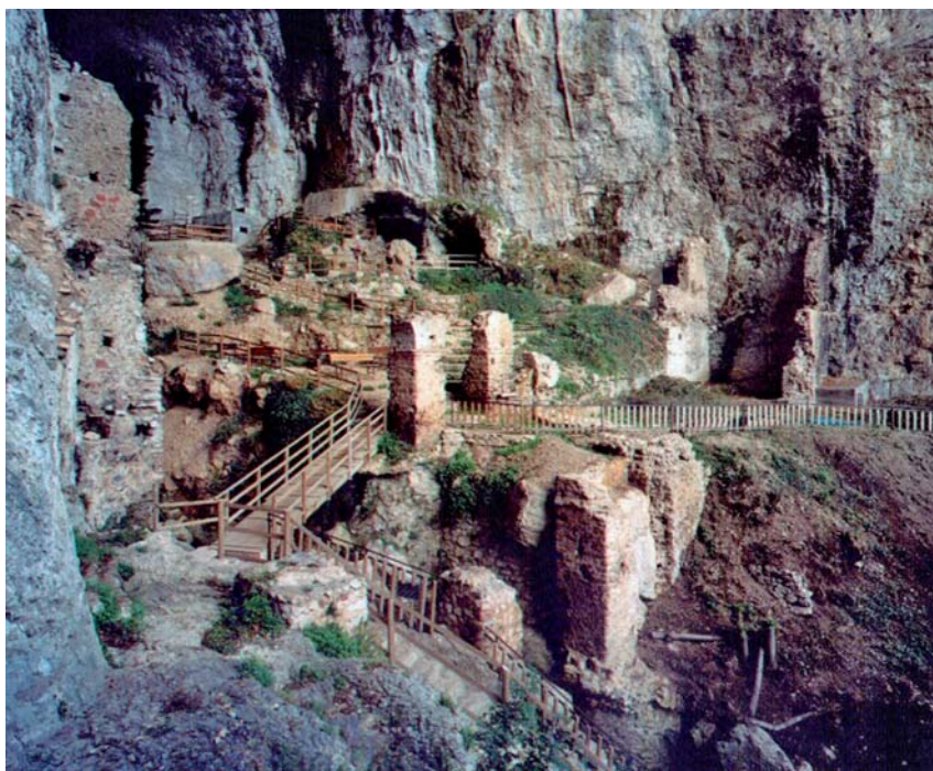
Fig. 2 - Resti delle strutture murarie del Buco del Piombo.
